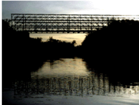
2da. Vista. Puente BAILEY (Tipo Doble-Triple) terminado en localidad de Minas de Corrales en apoyo a Minera San Gregorio.
