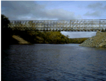
Puente BAILEY (Tipo Doble-Triple) terminado en localidad de Minas de Corrales en apoyo a Minera San Gregorio.
