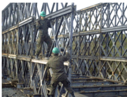
Personal armando la estructura Doble - Triple para apoyo a Minera San Gregorio (Minas de Corrales)
