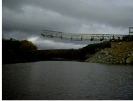
Lanzamiento del Puente BAILEY Tipo Doble-Triple en localidad de Minas de Corrales
