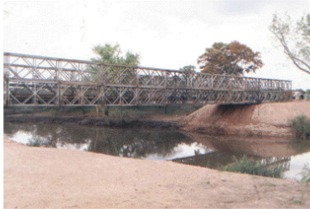
Puente BAILEY ( Estructura Doble- Doble ) conectando el Balneario "Las Cañas" con la ciudad de Fray Bentos.-
