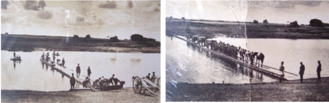
Etapas de Construcción del puente militar sobre el Río Santa Lucía ( Año 1921 )
